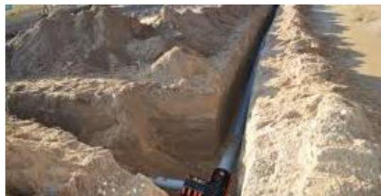
**Abb. 5.6:** Nahwärmenetz [vgl. 5.6]
