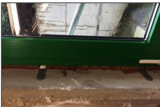
Abb. 5.3: Fenstereinfassung im Schulkeller 4
