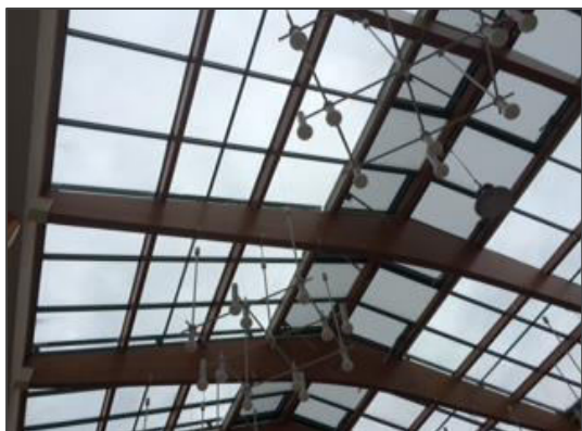
Abb. 5.2: Dacheindeckung in der Schulaula 4
