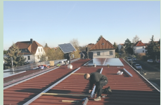
Gute Bedingungen: Der Ausfall des Winters im Dezember erleichterte den Handwerkern die Installation der Solarmodule. Fotos: A. Dreilich
